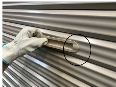
②片側側面のツメ (上記赤丸部) を差し込む
