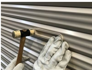
③ツメを差し込んだ反対側をプラスチックハンマーで叩き込み反対側のツメを嵌め込む
