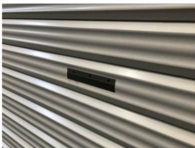
③ツメを差し込んだ反対側をプラスチックハンマーで叩き込み反対側のツメを嵌め込む
